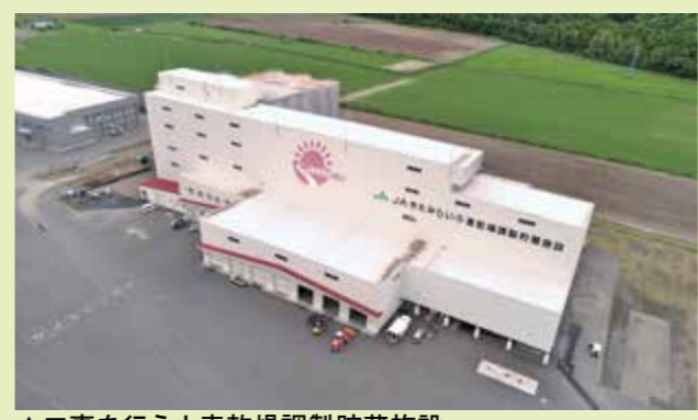
▲工事をを行う小麦乾燥調製貯蔵施設
